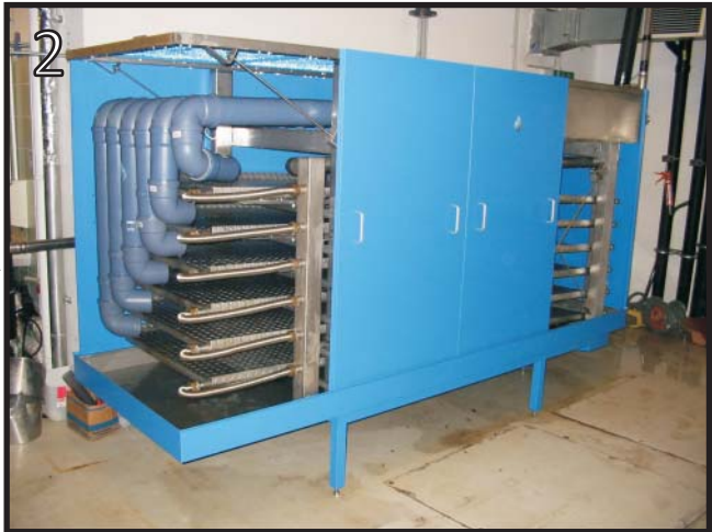
Oben im FB-Gehäuse befindet sich die Abwasserverteilerwanne. Hier wird der Abwasserstrom gleichmäßig auf alle Absorberebenen verteilt. Im Falle einer Überlastung fließt das Abwasser über einen Notüberlauf ab.
