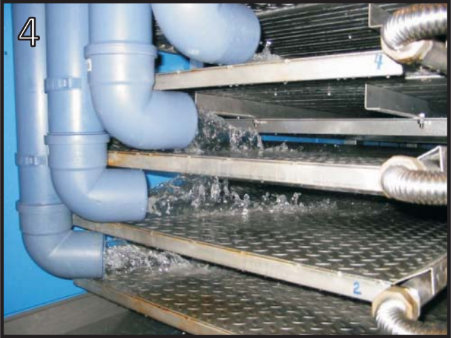
Oben im FB-Gehäuse befindet sich die Abwasserverteilerwanne. Hier wird der Abwasserstrom gleichmäßig auf alle Absorberebenen verteilt. Im Falle einer Überlastung fließt das Abwasser über einen Notüberlauf ab.
