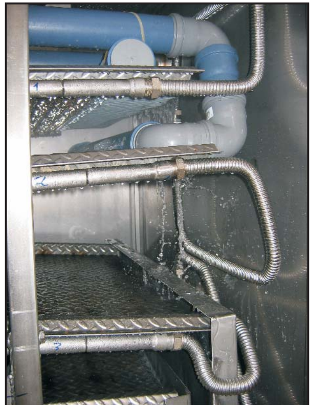
Foto: FERCHER Abwasserwärmetauscher Typ FB-8/S im Betrieb
