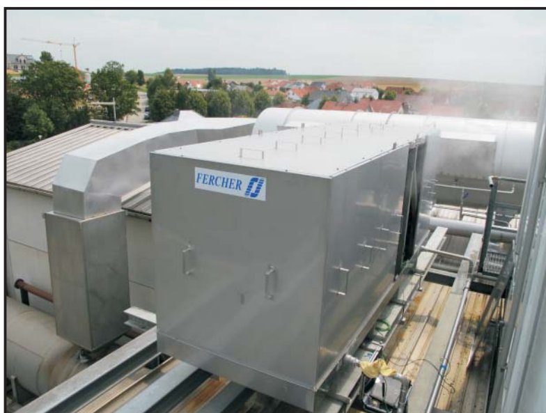
Foto: FERCHER Abwasserwärmetauscher Typ FB-12/WS am Dach in Nähe des Sprühtunnels montiert
