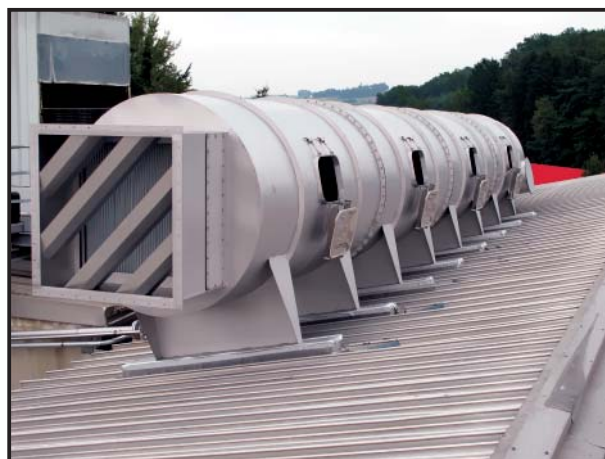
Foto: FERCHER Energiesprühtunnel Typ EST-D-1800 Montiert am Dach, Tropfenabscheider und gerichteter Abluftauslass
