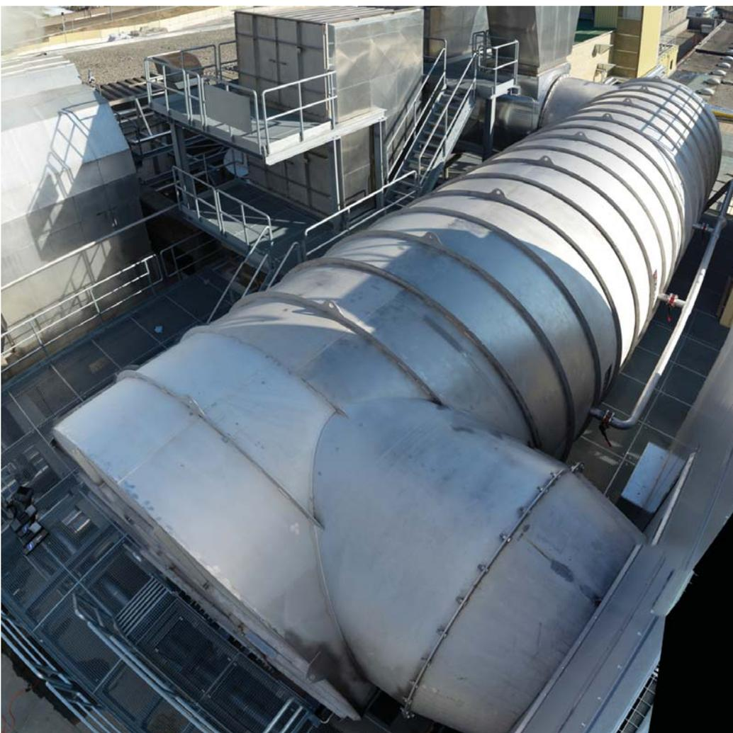
Bild oben: Sprühtunnel im Betrieb, auf dem Dach einer Papierfabrik
