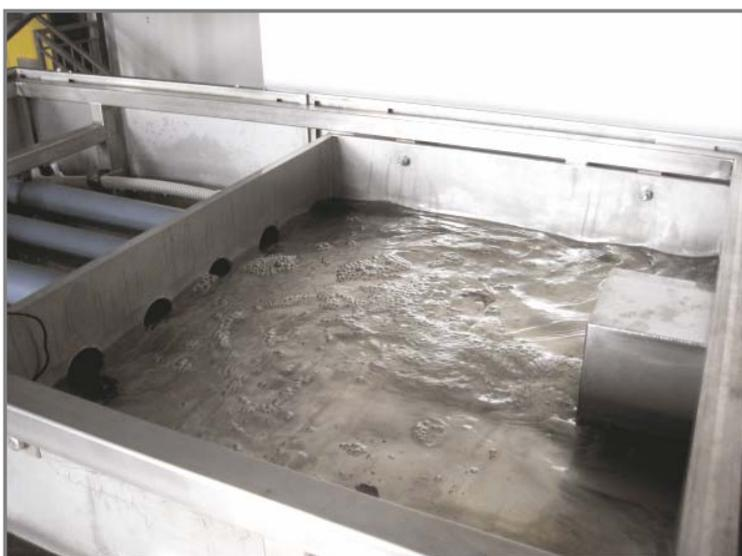
Die Abwasserverteilerwanne im Wärmetauscher verteilt das anfallende Abwasser gleichmäßig auf die 4 Polokalrohre, die das Abwasser auf die jeweiligen Absorberplatten verteilen.
